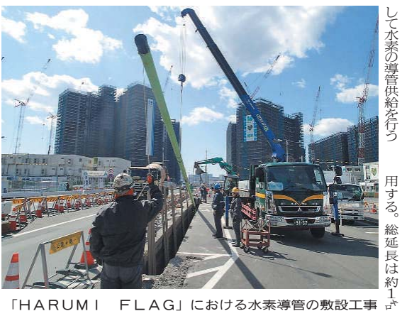
「HARUMI FLAG」における水素導管の敷設工事
