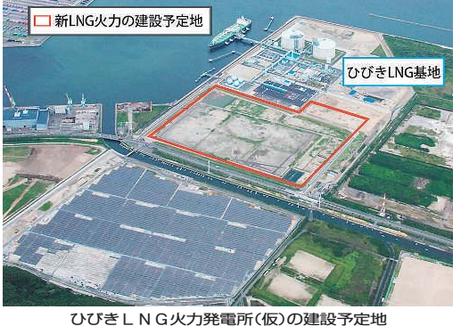
ひびきLNG火力発電所(仮)の建設予定地
