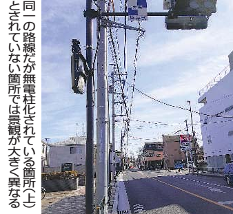
同一の路線だが無電柱化されている箇所上と下とを比較している。左側は電柱が立ち並ぶ様子、右側は無電柱化された様子。
